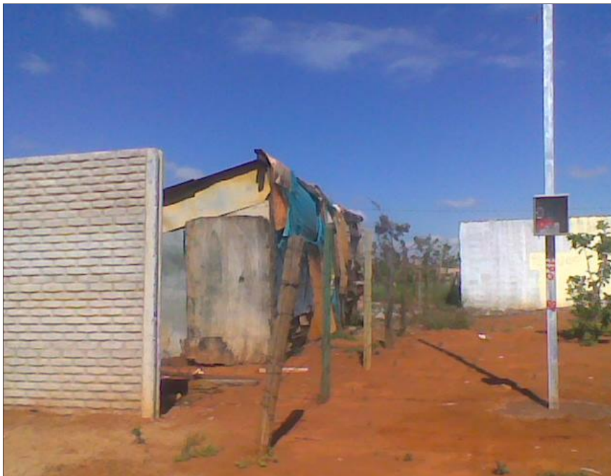
Foto 8: Moradia complementada com lonas.
