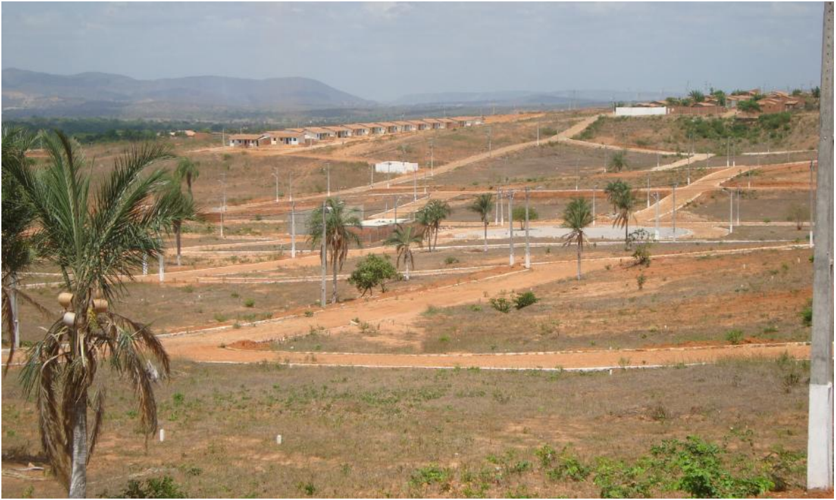
Figura 3. Bairro São José: degradação e urbanização. Área periférica em Juazeiro do Norte, em menos de cinco anos toda essa área foi degradada em prol da especulação imobiliária.
