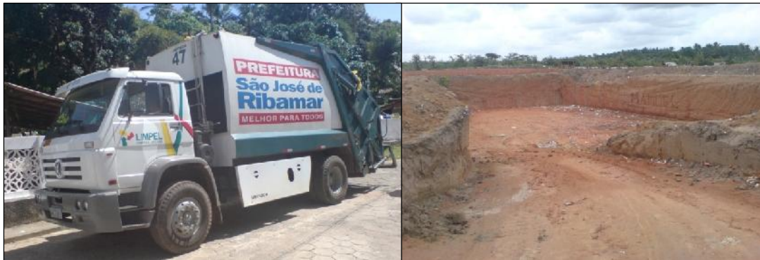
Figura 4 – Caminhão de coleta LIMPEL e Escavações para depósito de resíduos sólidos
