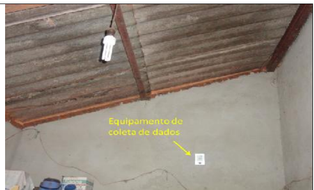
Fig. 4 – Localização do equipamento de coleta de dados (Termo-higrômetro) na residência com telha de fibrocimento.
