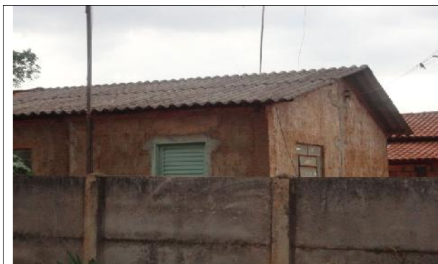
Fig. 3 – Residência com telhado de fibrocimento, em Guapó(GO).
