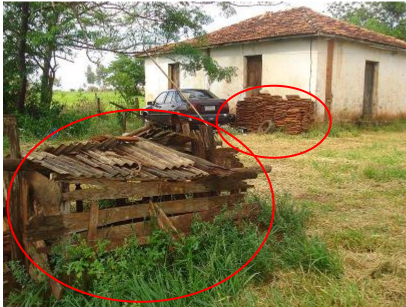
FIGURA 07 – casa abandonada ao lado da habitação apresentada na figura anterior, próxima ao Morro e tendo a poucos metros um pequeno galinheiro e um amontoado de telhas (em destaque). Lote 50, do assentamento Vale Verde. FONTE: Guttierre Paschoa (08/11/2008)
