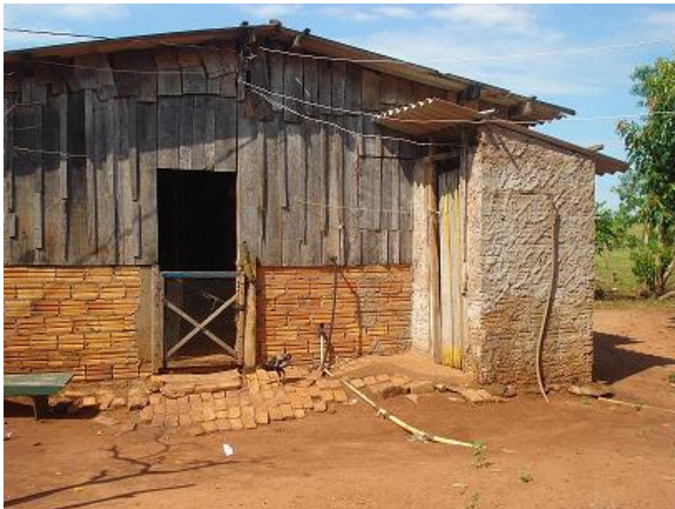
FIGURA 05 – habitação de madeira com base de alvenaria. Lote 17, do assentamento Haidéia. FONTE: Gutierrez Paschoa (08/11/2008)
