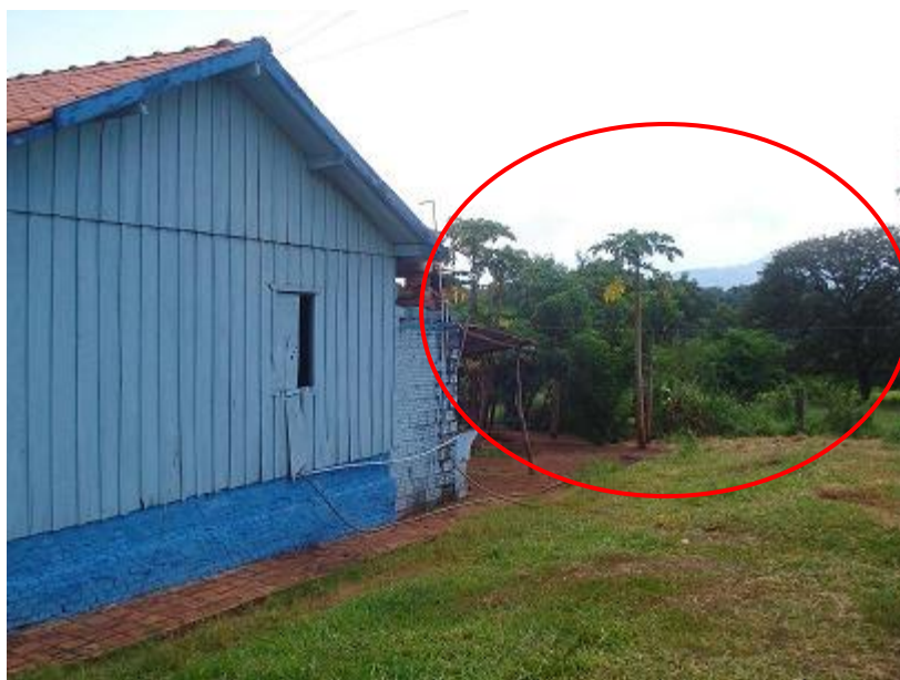
FIGURA 06 – habitação de madeira, com padrão mais seguro, porém à poucos metros da encosta do Morro do Diabo (destacado ao Fundo). Lote 50, do assentamento Vale Verde. FONTE: Gutierrez Paschoa (08/11/2008)
