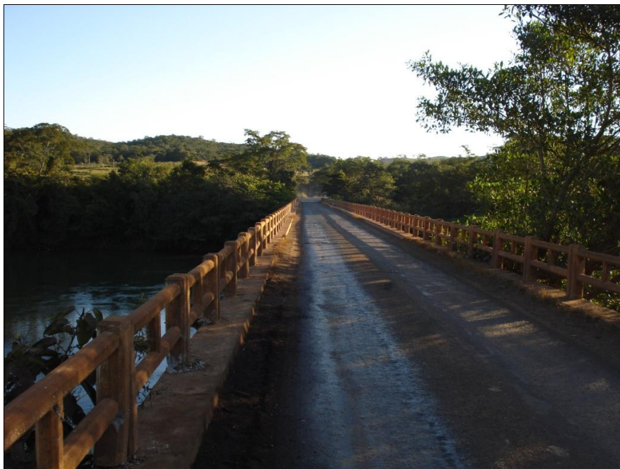
Foto 1- Ponto 2 - Ponte das Carapinas - área do aproveitamento hidrelétrico da Serra do Facão, Setembro de 2008.
