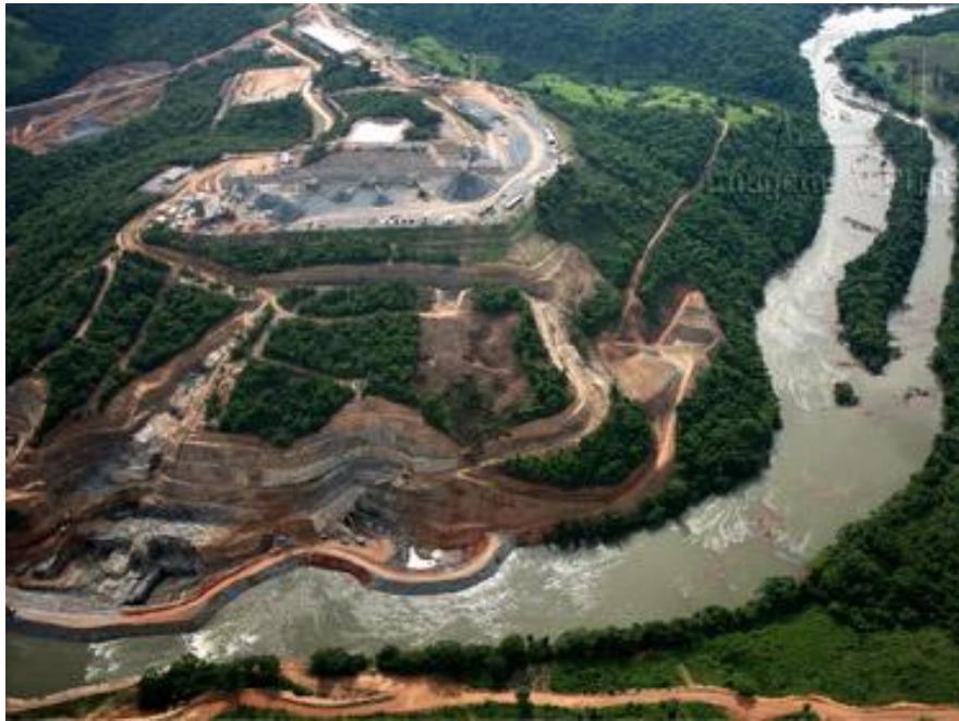
Figura 3 - Foto aérea panorâmica da área do canteiro de obras do AHE Serra do Facão, em Goiás, Brasil Fonte: http://www.alcoa.com/brazil/pt/custom_page/environment_serradofacao.asp . Acesso em 30/06/09.
